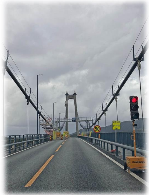
Vedlikehald på Bømlabrua. Foto: Bømlo kommune
