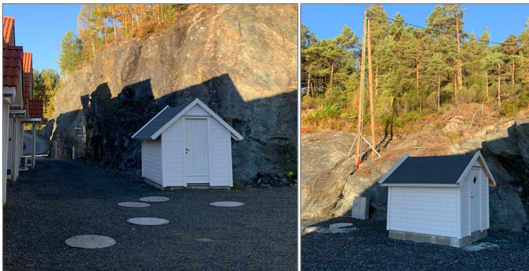
Figur 32 Pumpehus ved VA1 og VA2
