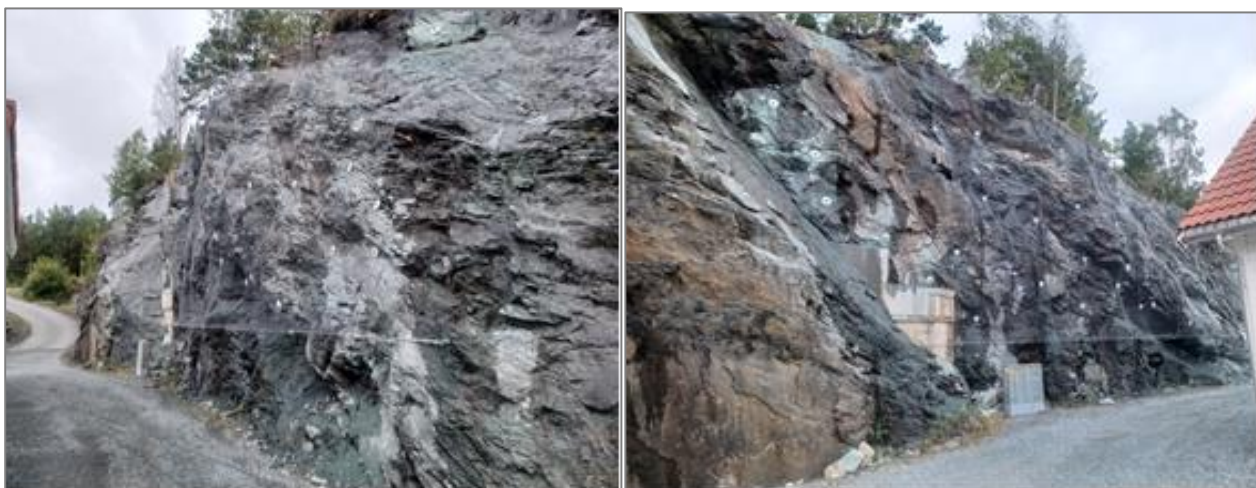
Figur 46 Bilete som syner utført sikringsarbeid i bakkant av UNB1-2
