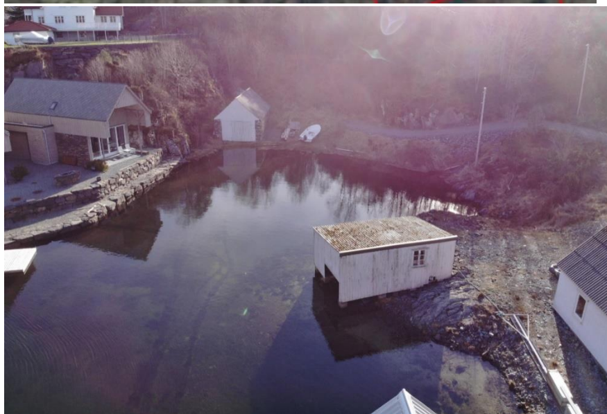
Eksisterande naustbygg på 137/19
